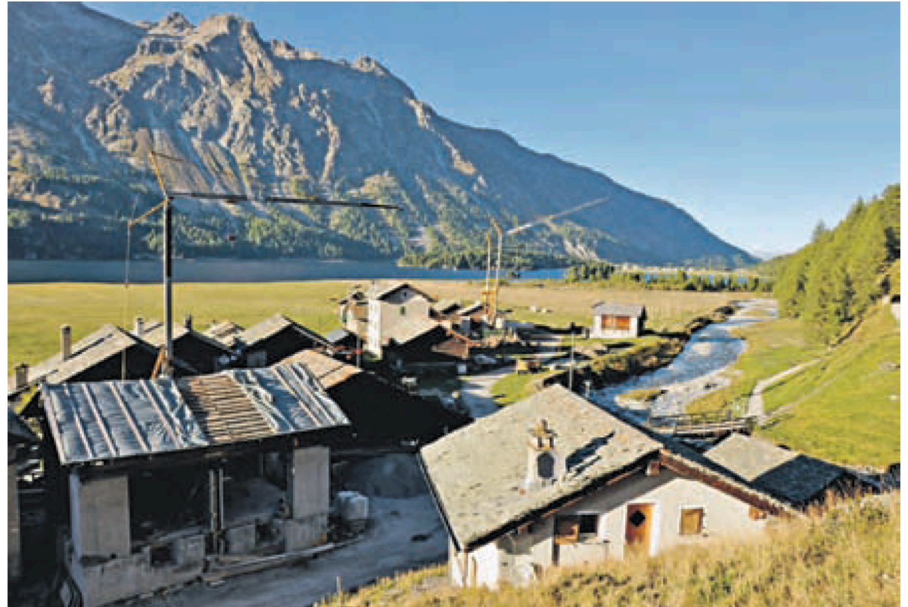
Unübliches Bild für Isola: Im Weiler wird gebaut.
