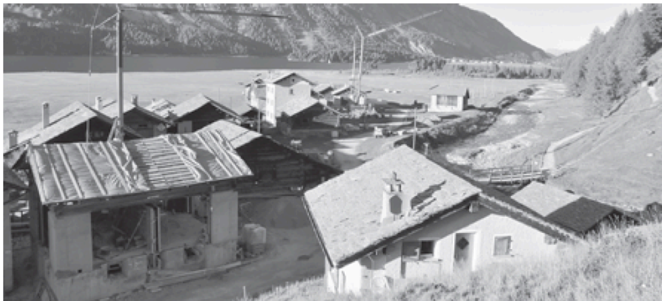
Isola im letzten Herbst: Im Kern des Weilers werden Ställe zu Wohnbauten umgebaut. Am Rand der Siedlung künden Bauprofile den geplanten neuen Stall an.
