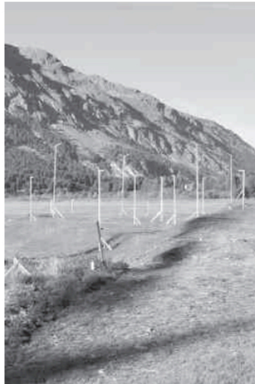
Profilstangen für den Stallneubau auf Isola.
