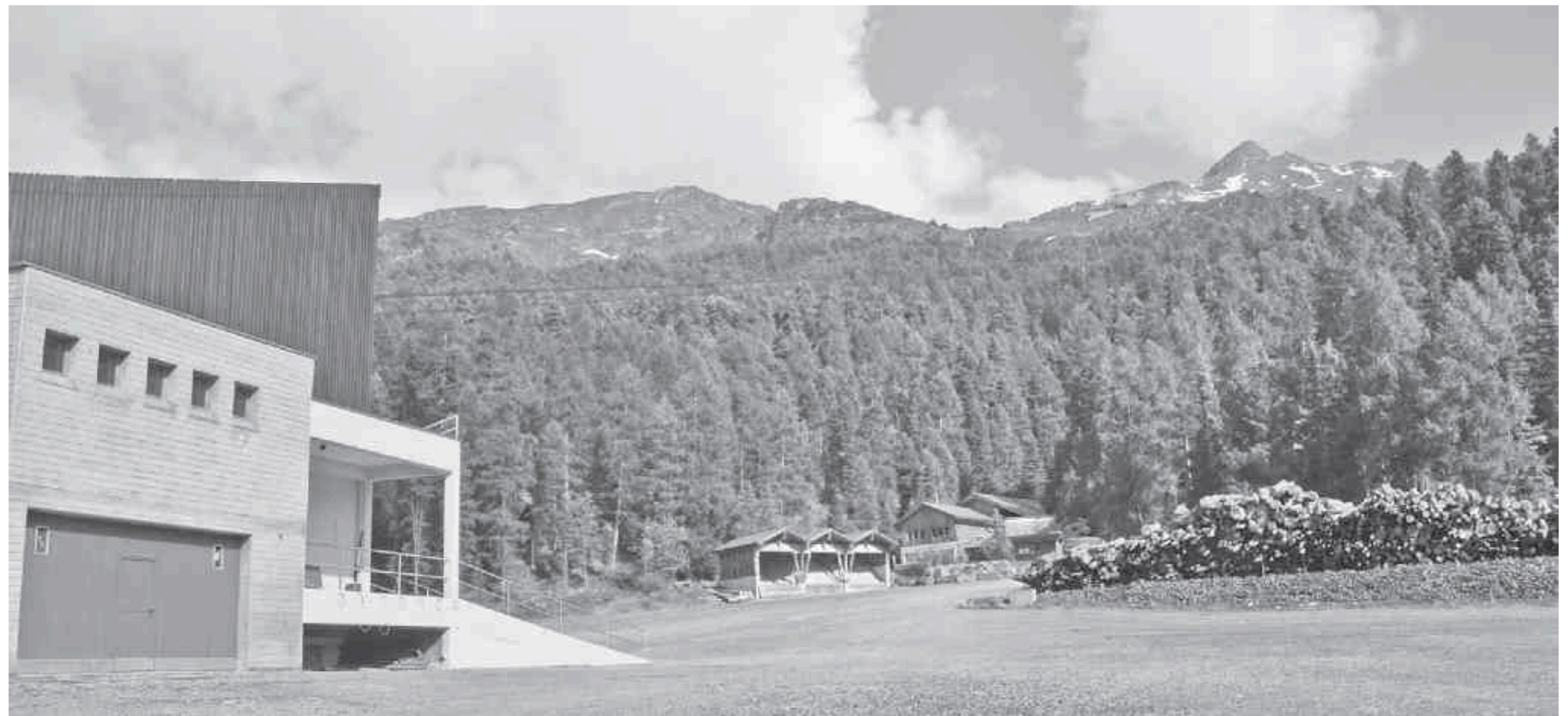
Die Talstation der Furtschellas-Bahn, wie sie sich heute präsentiert. Sie soll in eine Hotelüberbauung integriert werden. Die Talabfahrt wird nicht mehr zwischen Forsthof und Holzlager führen.
