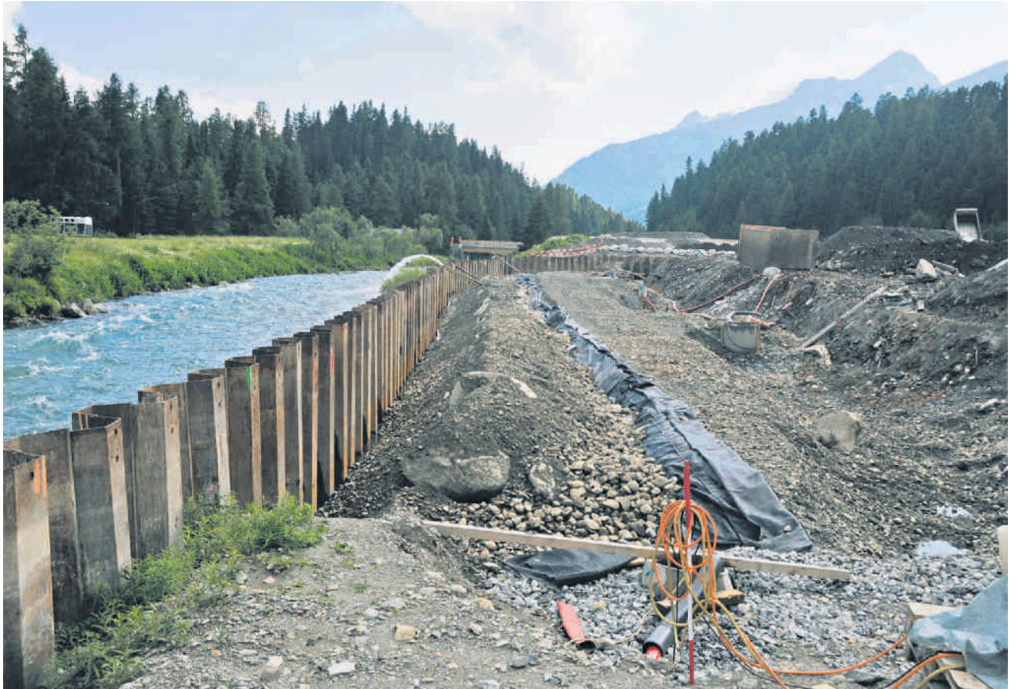
Die Sanierungsarbeiten der Deponie Islas sind in vollem Gange.
