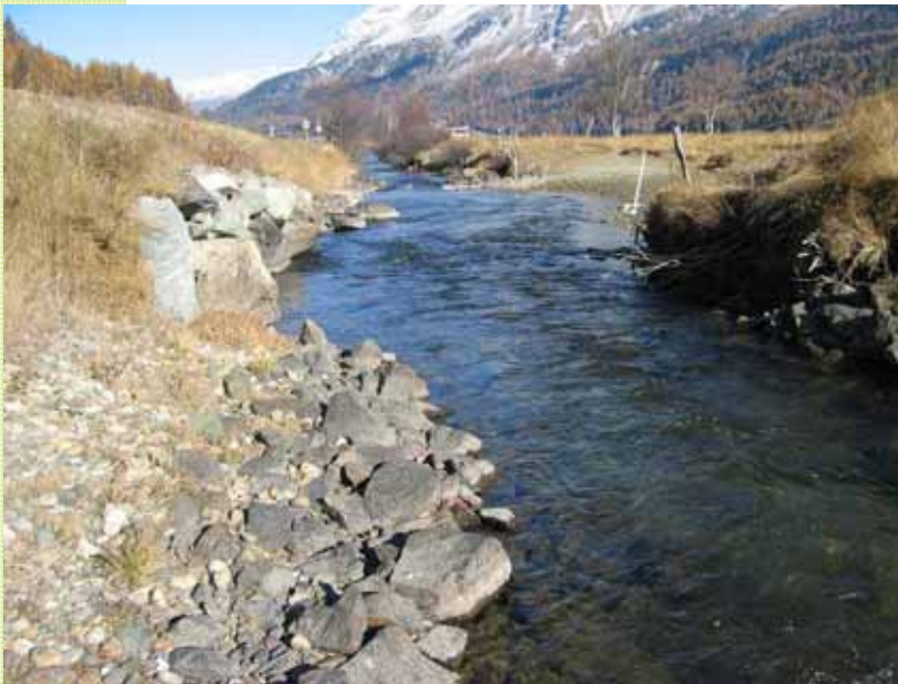
Abbildung 37: Sela im Abschnitt 1 mit eingeschränkter Wasserspiegelbreitenvariabilität. Im Bild eine kleinräumige Aufweitung, wo der Böschungsfuss nach Abschwemmung nicht mehr repariert wurde. (Foto DR, 31.10.2007)
