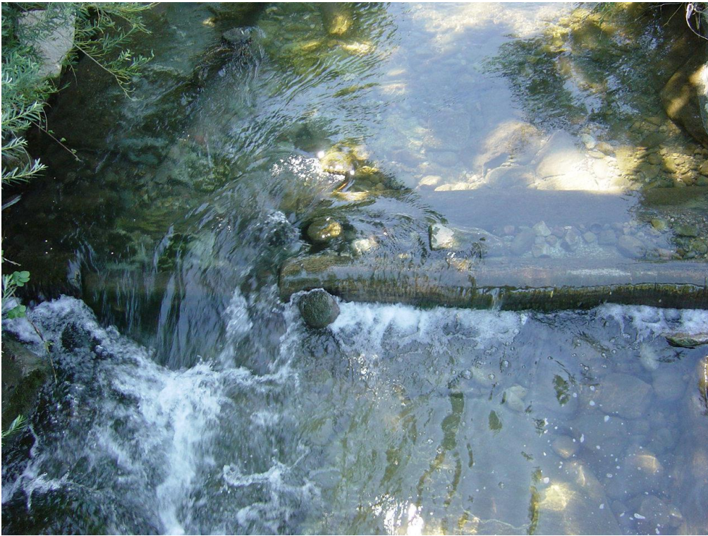
Bild 18. Schwelle aus Holz am Laveggio bei Capolago TI. Dank der Verringerung der Breite des Gerinnes bei der Schwelle, können Fische auch bei geringer Wassermenge aufsteigen.
