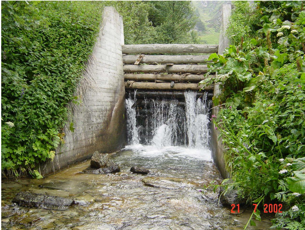
Bild 12. Rückhaltebecken. Ansicht von unten.
