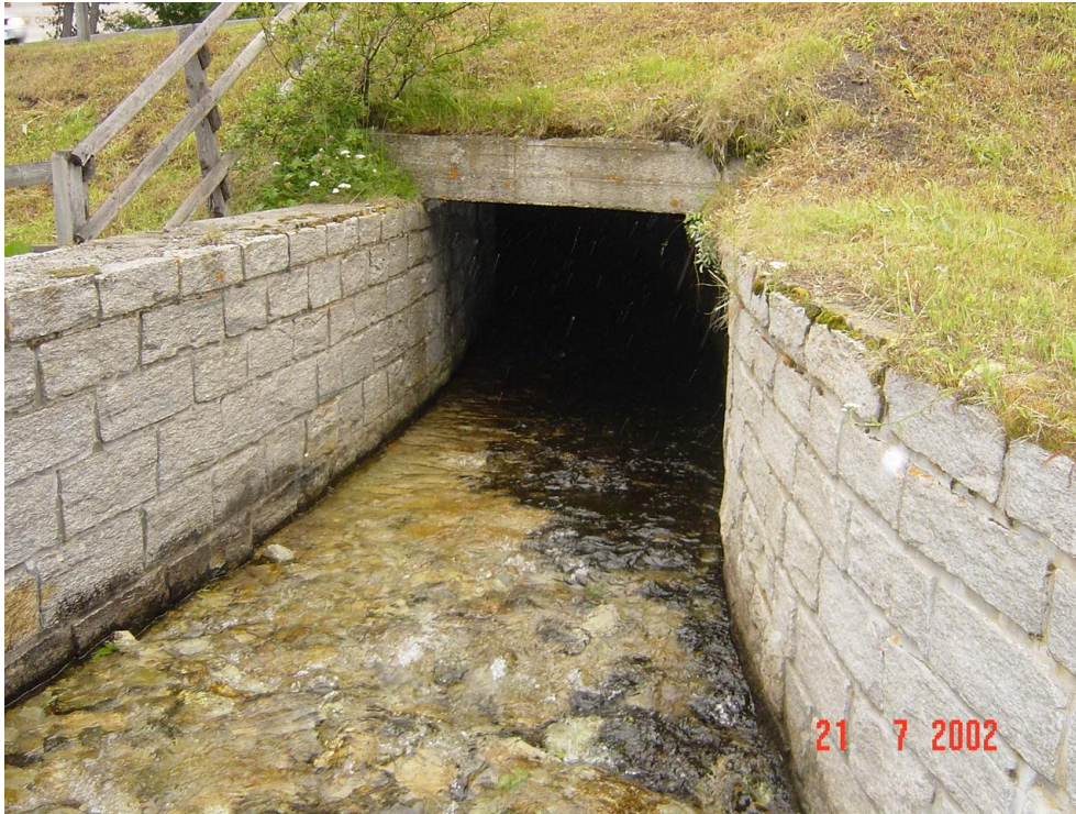
Bild 8. Unterführung Kantonsstrasse. Eingang.
