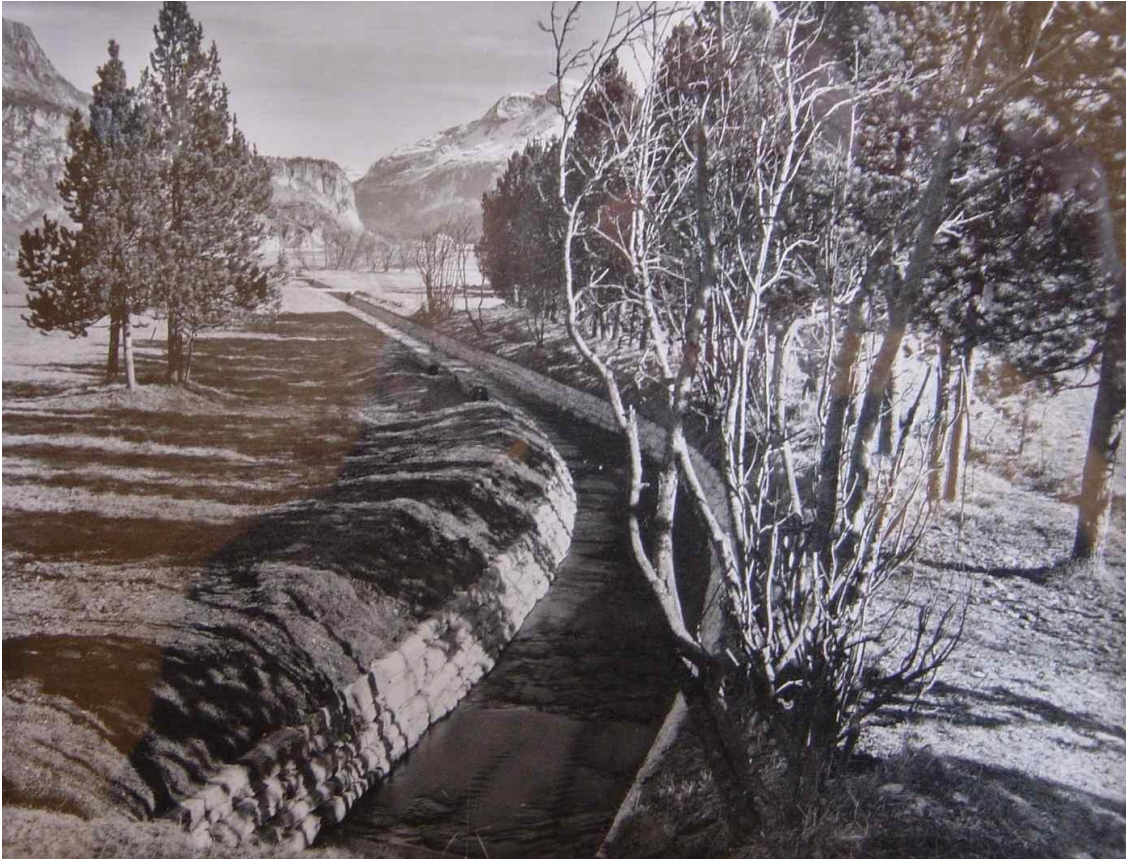
Bild 3. Letzte 400 m Fliessstrecke bis zur Mündung in den Silsersee. Gut ersichtlich sind die Seitenmauern. Bild aus den fünfziger Jahren.
