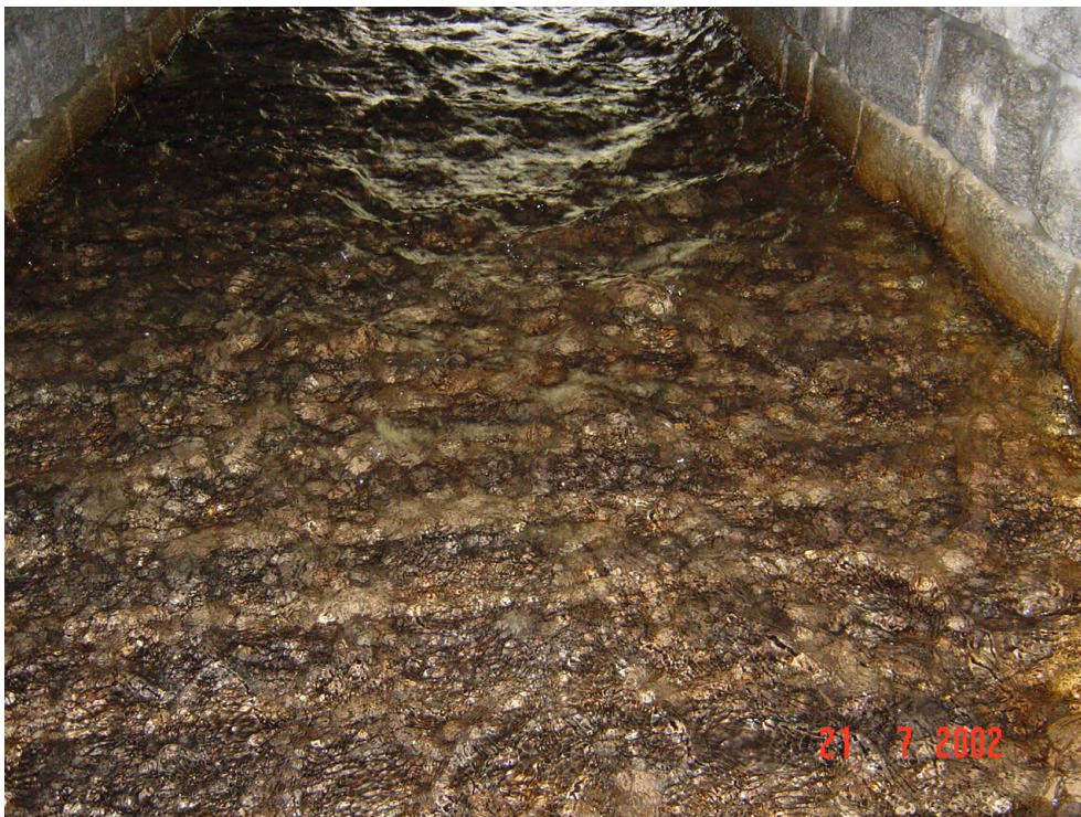
Bild 11. Die Sohle ist mit Steinen gepflastert. Wegen der relativ grossen Breite des Gerinnes ist die Wassertiefe gering.
