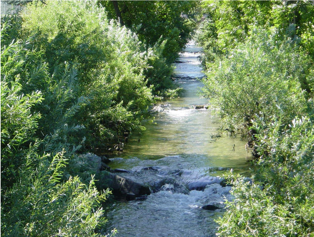
Bild 20. Renaturierung des Laveggio bei Capolago TI. Es wurden alternierend Schwellen aus Holz und Schwellen aus Steinen gebaut.
