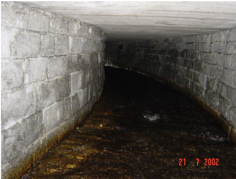
Bild 10. Unterführung Kantonsstrasse. Innenansicht.
