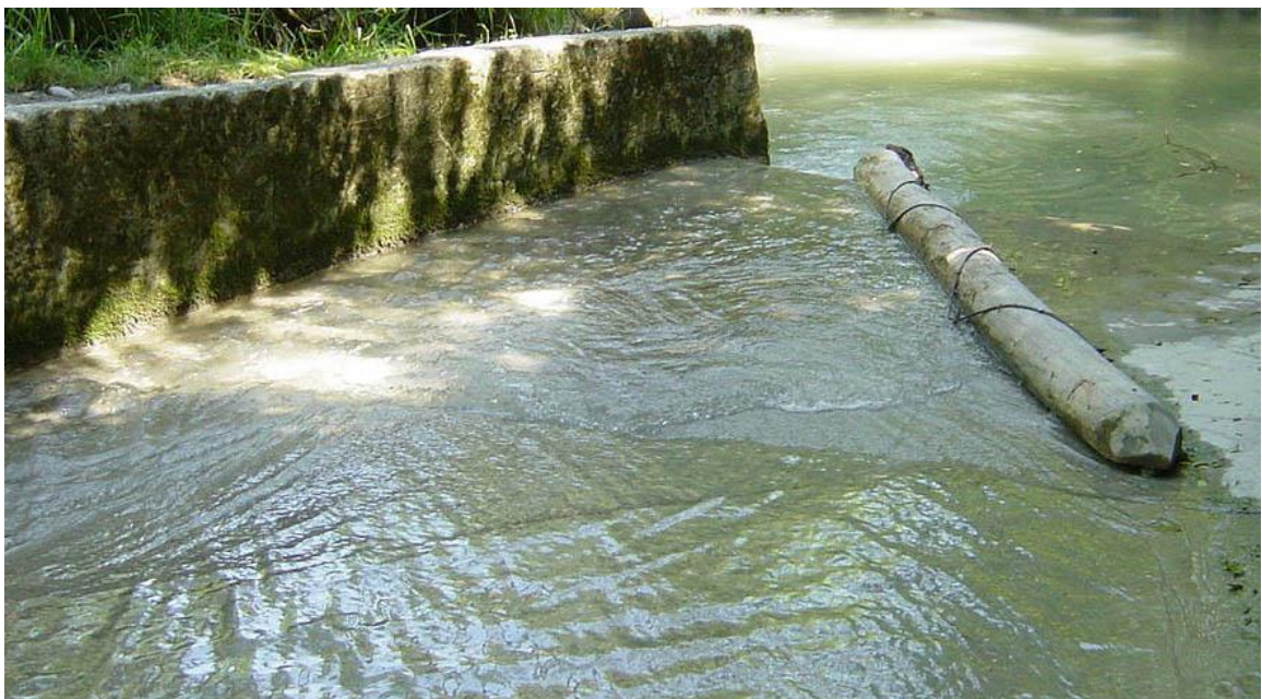
Bild 15. Beispiel für einen am Untergrund fixierten Baumstamm. Dieser lenkt fast das ganze Wasser auf der linken Seite ab.
