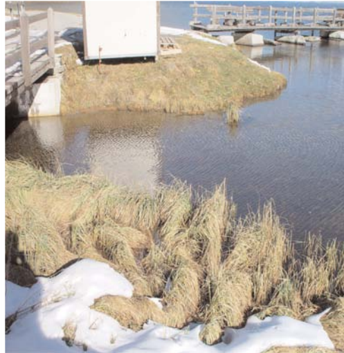
Abb. 2.3-12: Innmündung unter der Seeweg-Brücke
