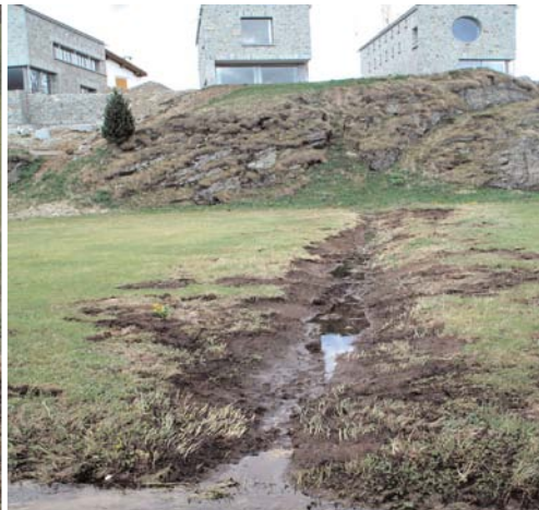
Abb. 2.1-13: Neu gegrabene Dränung zum Baselgabach.
