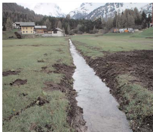
Abb. 2.3-14: Die Aua da la Val Baselga - kanalisiert zwischen Siedlungsraum und Verdolungsstrecke.
