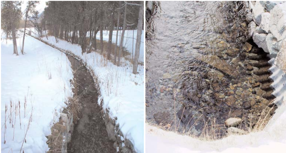
Abb. 2.3-8: Steinrinne Höhe Palace-Hotel, Übergang mit abnehmender Mauerhöhe
