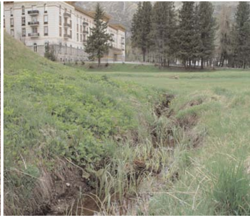
Abb. 2.1-11: Verdolter Wiesenbach unterhalb Maloja-Palace.
